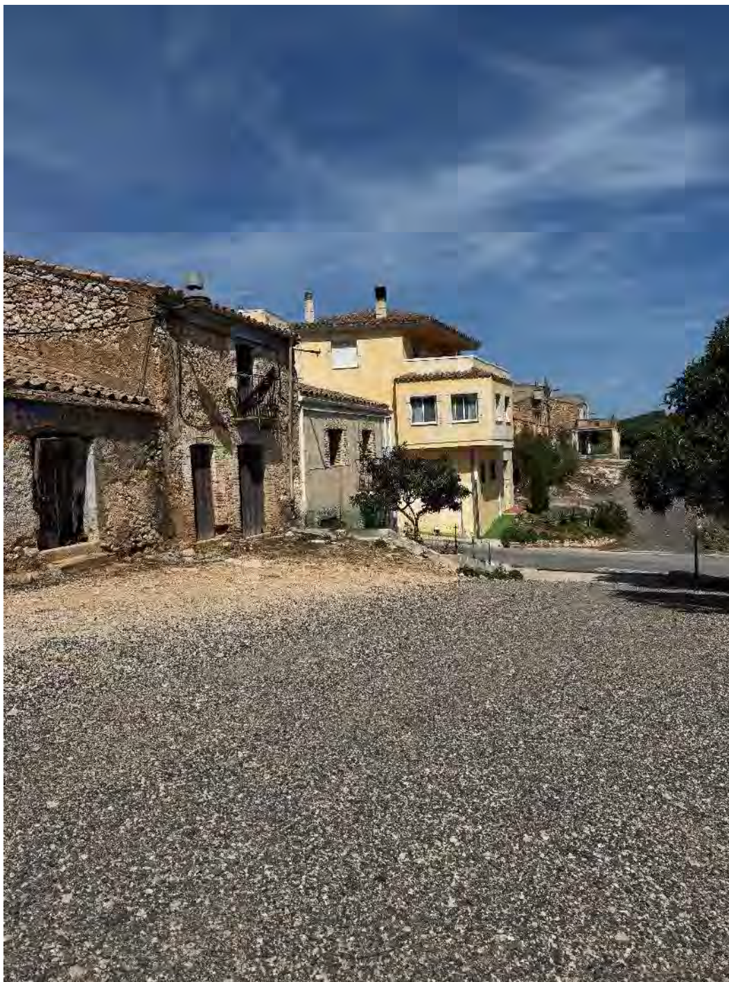
Imatge 1. Vista cap a l'est del carrer Tramuntana
